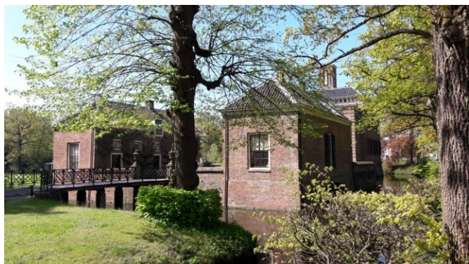
Figuur 2.2: Buitenplaats Gunterstein achterkant. Bron: Eigen foto
