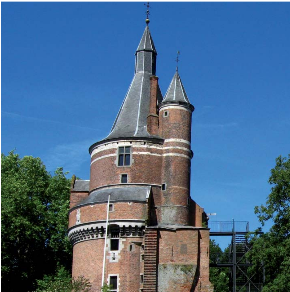
Duurstede. De Bourgondische toren met rechts de stalen brandtrap. Foto auteur.
