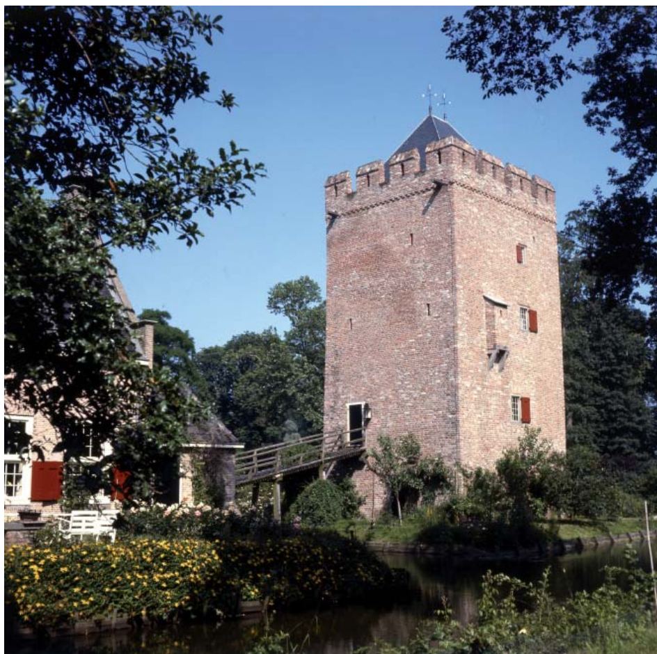
De reconstructie van de woontoren van kasteel Lunenburg. Foto Doriann Kransberg, 1978.
