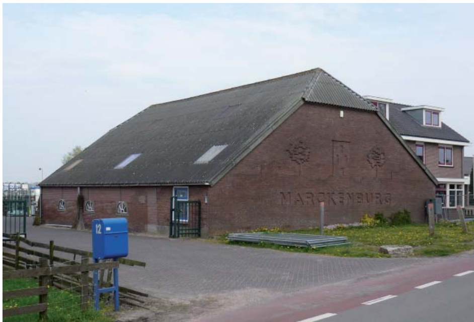
De boerderij Markenburgh in Schalkwijk met in de vroegere voorgevel in siermet-selwerk de contouren van het kasteel, die als woontoren is voorgesteld.
