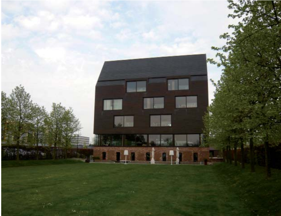
Van het zeventiende- eeuwse landhuis De Wiers (Vreeswijk) bleef het souterrain bewaard. De hoofd- vorm van het landhuis is bij de nieuwbouw in 2005 hersteld. De gracht is niet opnieuw uitgegraven.
