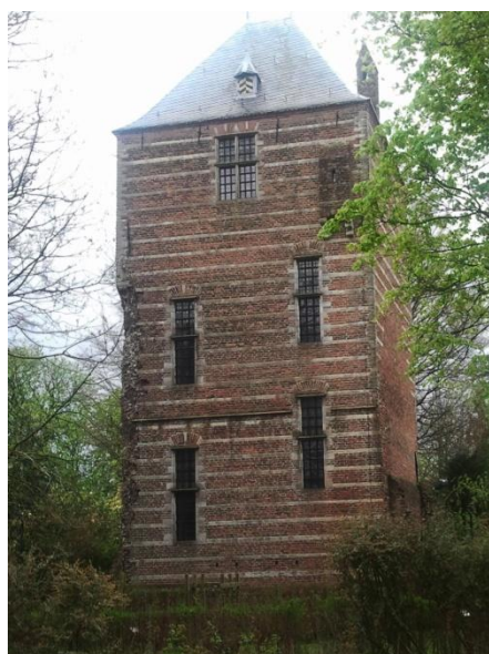
Figuur 4.3: De Kasteeltoren in zijn huidige staat
