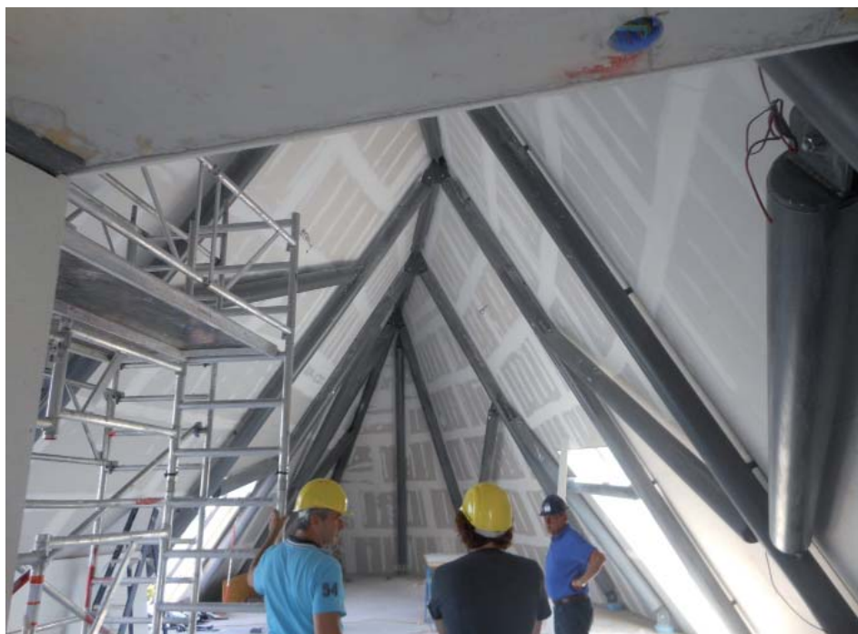
Interieur bovenste herbouw-etage tijdens herbouw.
