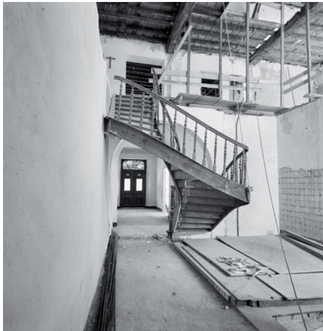
Interieur Kasteel de Raay tijdens de verbouwing.
