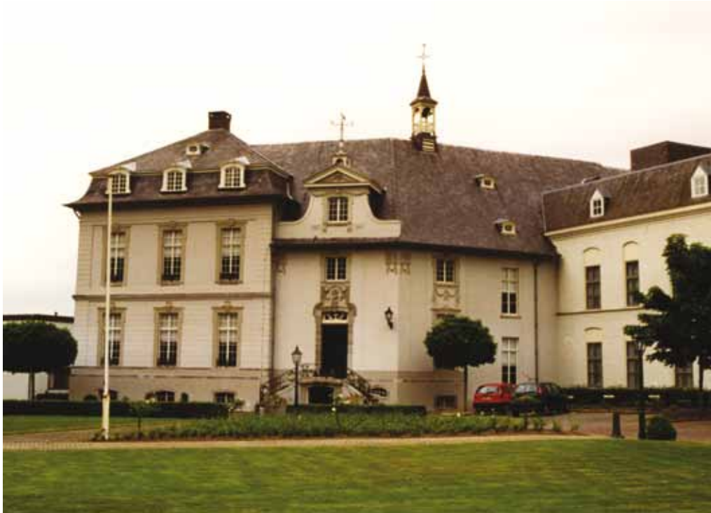
Kasteel Boxmeer in Boxmeer. Te zien is één van de zijvleugels van het voormalige buitenhuis. De andere zijvleugel is gesloopt. Foto: collectie NKS.
