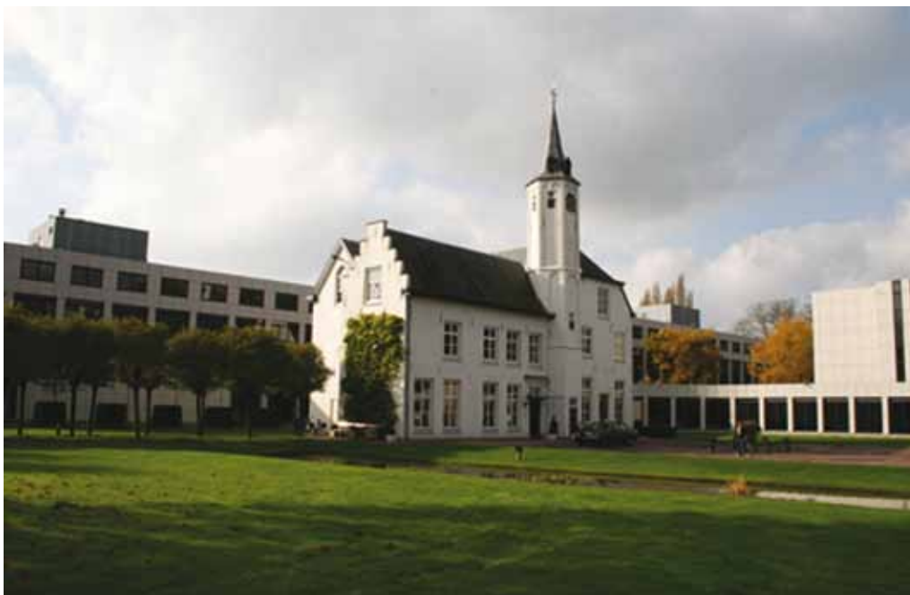
De (Grote) Ruwenberg als Opleidings- en Conferentiecentrum, 2008. Te zien is hoe het oorspronkelijke ‘beschermd’ kasteelgedeelte behouden is gebleven. Er om heen is een gedeelte te zien van de nieuwbouw die rond het kasteel werd opgetrokken nadat dit gebouw rond 1988 een nieuwe functie kreeg.
