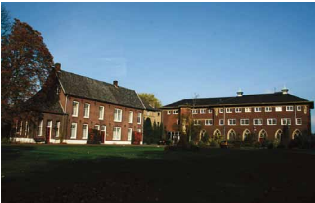
Rechts het rond 1934-1935 gebouwde hoofdgebouw van het klooster, op de plek van het voormalige zestiende-eeuwse huis. Links een van de twee oorspronkelijk achttiende-eeuwse bijgebouwen wiens interieur zal worden gerenoveerd. (Foto ongedateerd).
