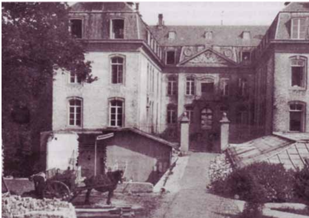
Kasteel Gemert in Gemert. Voorbereiding voor de bouw van de kapel in 1935.
