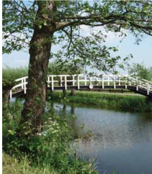
Een kwakel (boogbrug voor voetgangers) over de Lange Linschoten. De hoogte van de kwakels is al in de middeleeuwen bepaald ten behoeve van de scheepvaart. (Foto auteur)
