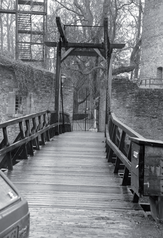
Brug naar het kasteel, afgesloten door een hek. Foto: auteur, 2011.
