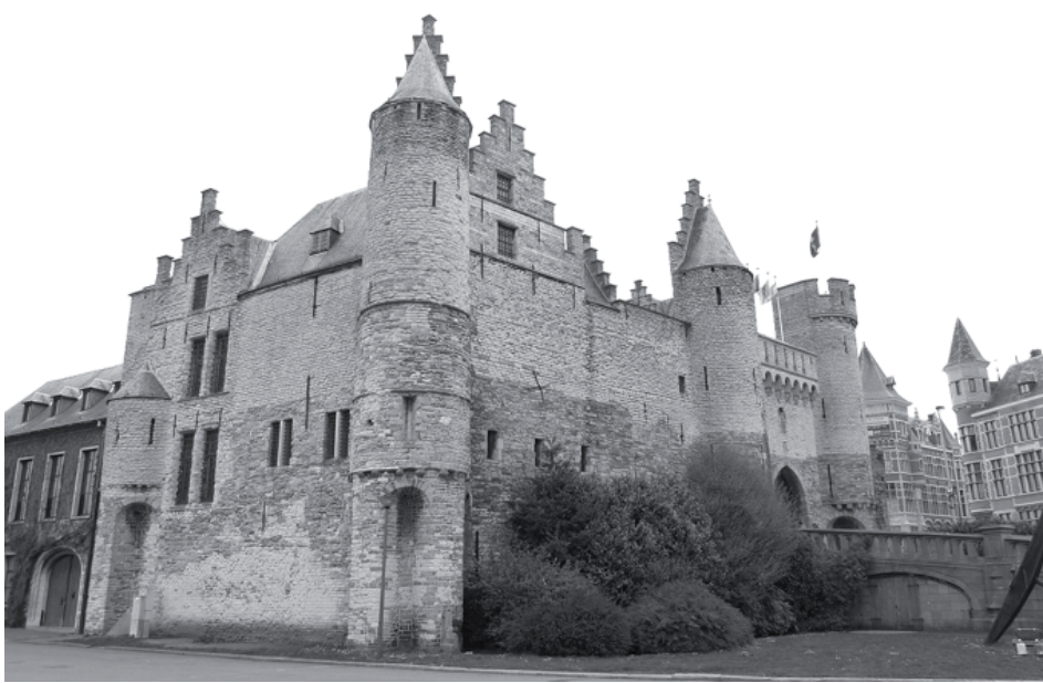
Het Steen. Thans in gebruik als scheepvaartmuseum, eerder een gevangenis. Foto: auteur, 2011.
