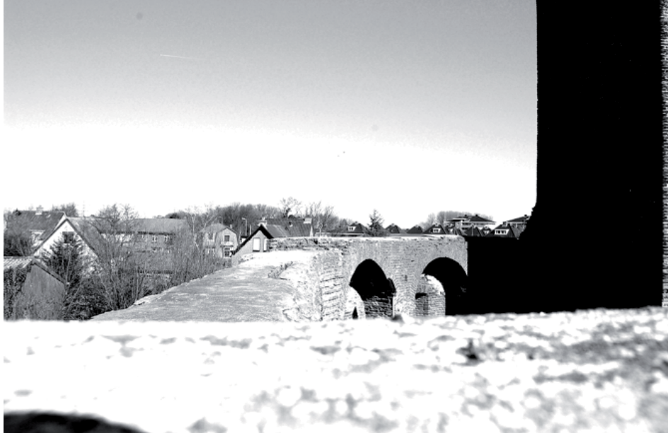
Foto genomen vanaf de traptoren in de ringmuur. Thans is de weergang voorzien van een laag cement, en is deze niet betreedbaar. Foto: auteur, 2011.
