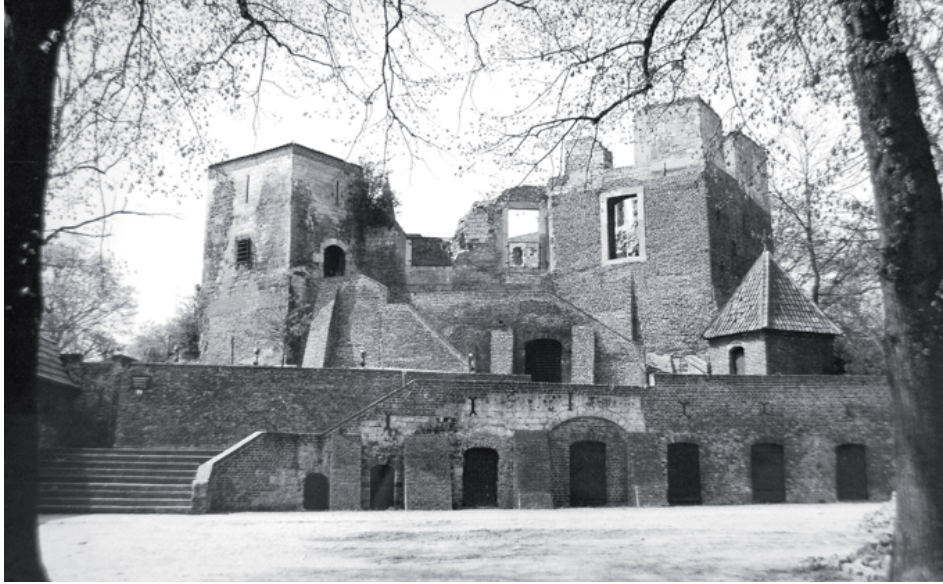
Kasteel Keverberg. De voorburch werd gereconstrueerd. Foto: archief NKS.
