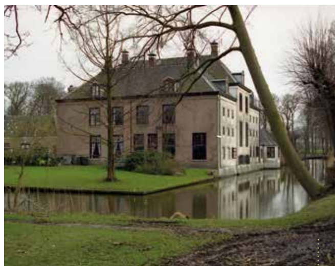
> GEZICHT OP DE LINKER- EN DE UIT DE GRACHT OPRIJZENDE ACHTERGEVEL VAN HUIS SCHOONHEETEN, COLL. NKS KENNISCENTRUM. FOTO P. VAN DER WIELEN.
