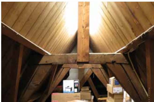
> EEN VAN DE SPANTEN OP DE ZOLDER. HET SPANT IS VAN EIKENHOUT EN STAMT UIT DE HERBOUWFASE EIND ZESTIENDE BEGIN ZEVENTIENDE EEUW. DE STIJL OP HET SPANT EN DE GORDINGEN WERDEN ROND 1922 AANGEBRACHT (FOTO AUTEUR).
