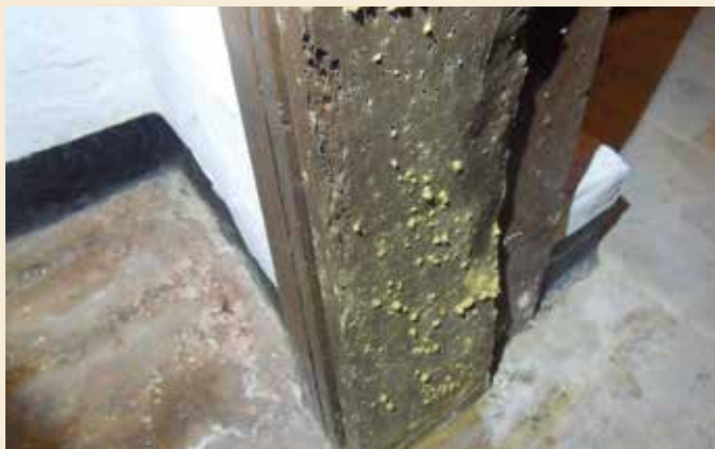
> DEURSTIJL AANGETAST DOOR HOUTBORENDE INSECTEN.
