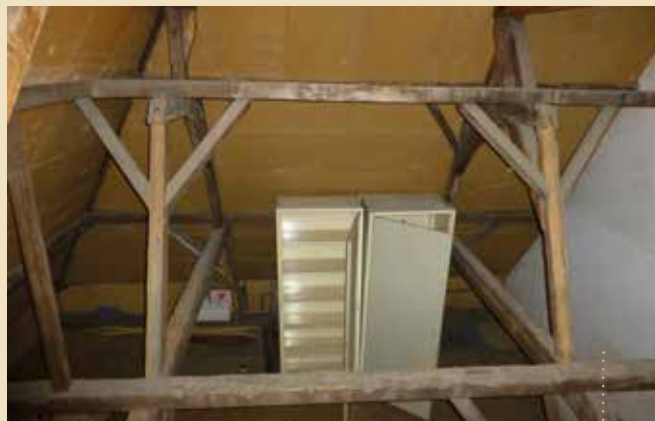
> ZICHT OP DE KAPCONSTRUCTIE. FOTO RACHEL HALVERSTAD.
