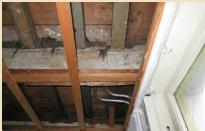
> DE ZOLDERVLOER BESTAAT NOG ALTIJD UIT EEN SAMENGESTELDE BALKLAAG VAN ZWARE MOERBALKEN MET DAARTUSSEN LICHTER KINDERBINTEN. FOTO AUTEUR.
