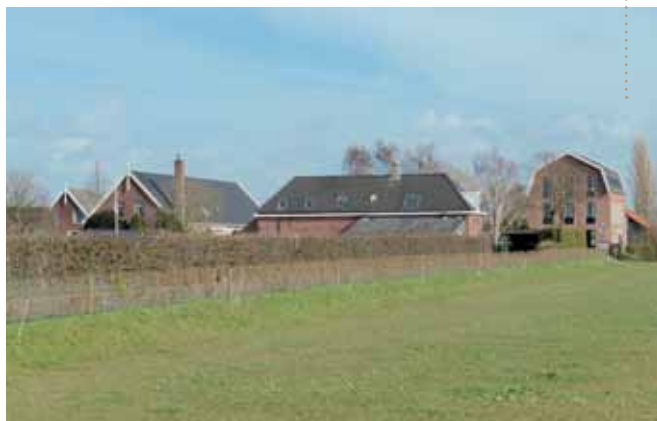
> GEZICHT OP HET COMPLEX IN 2015 VANUIT HET WESTEN. LINKS DE VERNIEUWDE BOERDERIJ (WASBEEKLAAN NR. 31). IN HET MIDDEN HET OORSPRONKELIJKE KOETSHUIS (NR. 27) EN RECHTS EEN VERBOUWDE BOLLENSCHUUR (NR. 25), DEELS OP DE PLAATS VAN HET HUIS (FOTO KENNISCENTRUM KASTEEL EN BUITENPLAATS 2015)
