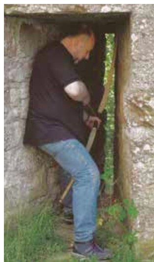
> AFB. 5 – EEN TE KRAPPE SCHIETNIS (LINKS) EN ALS GEVOLG DAARVAN EEN UITERST BEPERKT BLIKVELD (RECHTS) UIT BERNGES 2011
